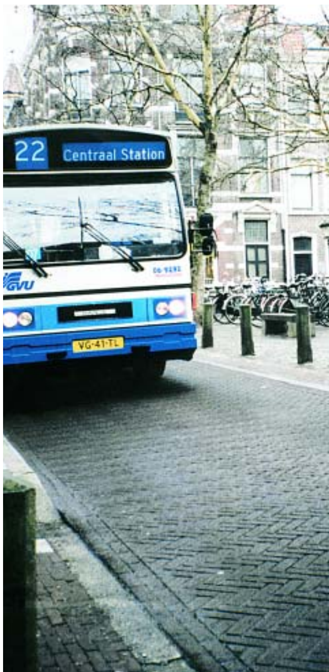
Φωτ. 2.1. Σταμπωτή ασφάλτος σε λεωφορειόδρομο
