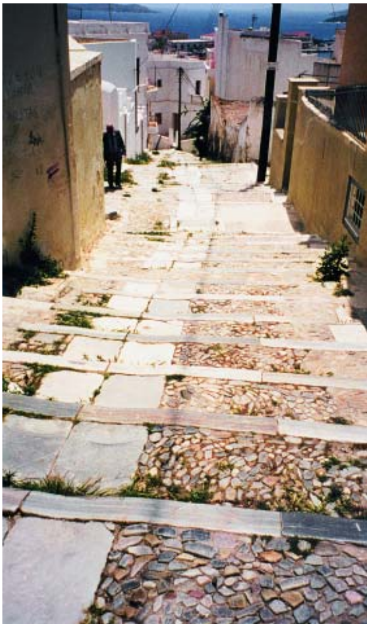
Φωτ. 2.6. Ερμούπολη. Σύρος. Λιθόστρωτη κλίμακα όπου συνδυάζεται πλακόστρωση στον άξονα, αγκωνάρια στα ρίχτια και μικροί λίθοι στα ενδιάμεσα τμήματα.
