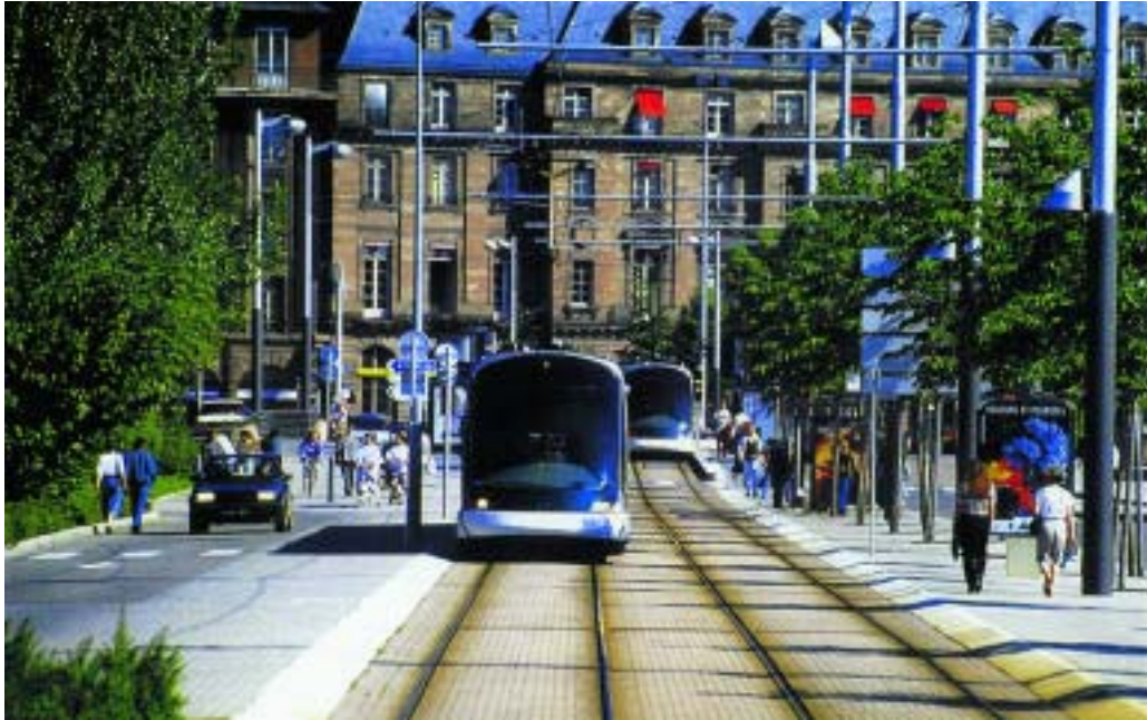
Φωτ. 2.12. Strasbourg, Γαλλία. Διάδρομος διέλευσης του τραμ σε χαμηλότερη στάθμη ως προς το πεζοδρόμιο, επιστρωμένος με κυβόλιθους.
