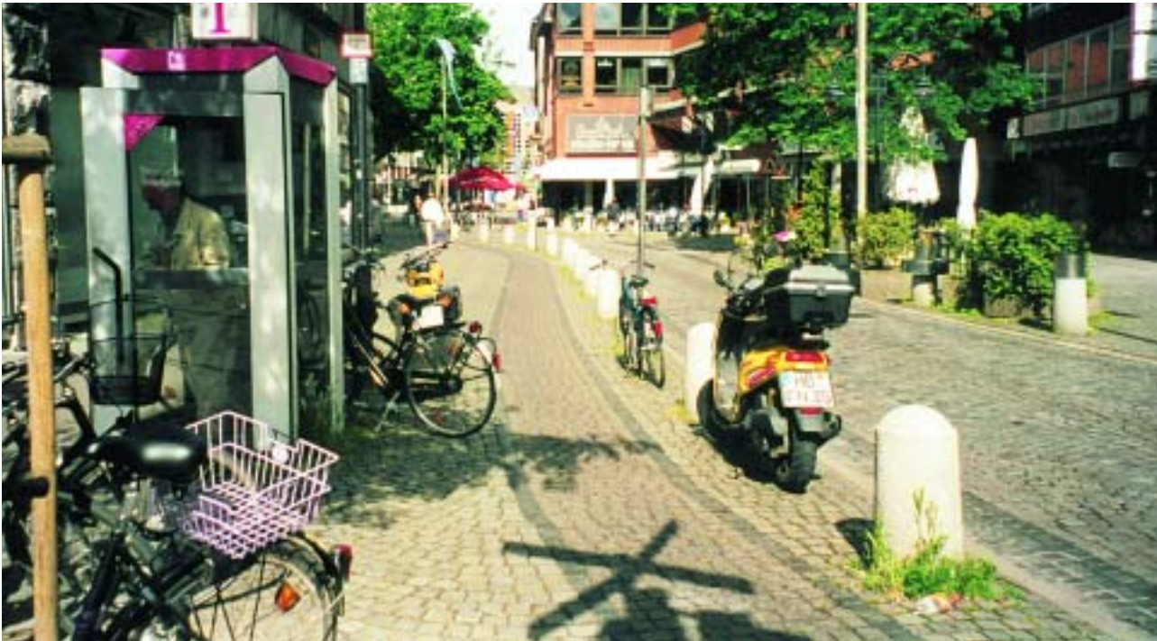
Φωτ. 2.2. Bremen. Γερμανία. Μια από τις σπάνιες περιπτώσεις διάσρωσης ποδηλατόδρομου με κυβόλιθους από πέτρα. Η σήμανσή του επιτυγχάνεται με τη χρήση κυβόλιθων από πέτρα πολλών χρωμάτων. Μια ανάλογη λύση οριοθέτησης με λωρίδες από κυβόλιθους έντονου χρώματος δίνεται και στο παρακείμενο οδοστρώμα.
