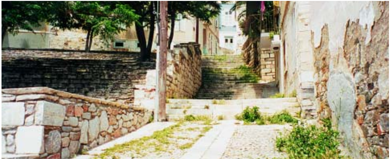
Φωτ. 2.15. Ερμούπολη, Σύρος. Λιθόστρωτη κλίμακα με χαρακτηριστική πλακόστρωση στον άξονα. Ο υπόλοιπος χώρος των σκαλοπατιών καλύπτεται από μικρούς λίθους που εγκιβωτίζονται ανάμεσα στα κράσπεδα και τις πλάκες. Σε πολλά σημεία ανάμεσα στους λίθους διακρίνεται το πράσινο. Η όλη κατασκευή της λιθόστρωτης κλίμακας εντάσσεται αρμονικά σε ένα περιβάλλον όπου η πέτρα είναι κυρίαρχη.
