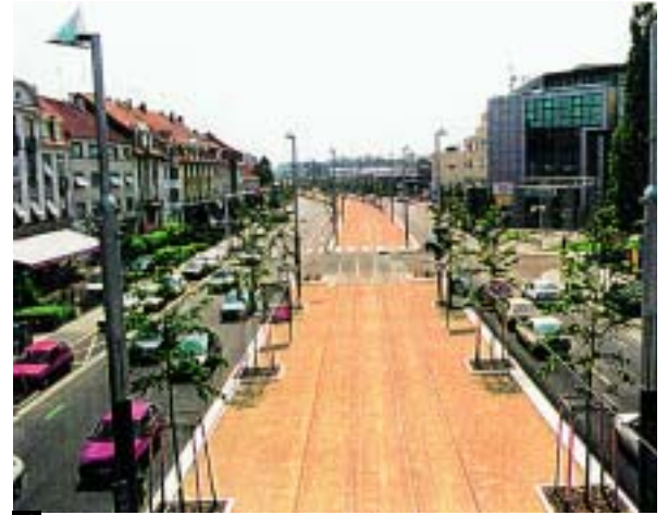
Φωτ. 2.14. Strasbourg, Γαλλία. Avenue Colmar. Κάλυψη του διαδρόμου του τραμ διαπερατή από το νερό με στρώση αδρανών. Στις δύο φωτογραφίες φαίνεται η λεωφόρος πριν (α) και μετά (β) την κατασκευή του τραμ. (Η φωτογραφία ανήκει στην Communauté Urbaine de Strasbourg ).
