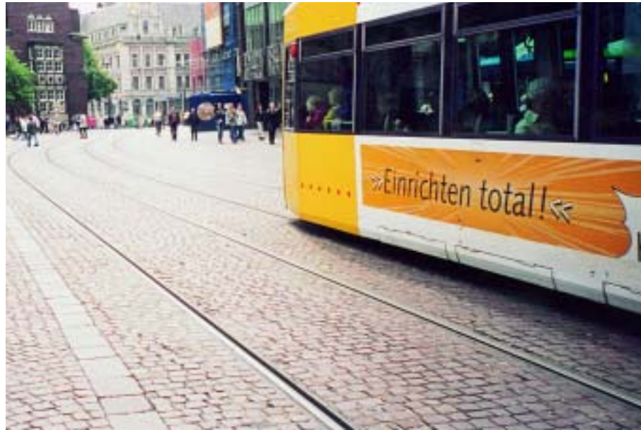
Φωτ. 2.3. Βρεμεν. Γερμανία. Κυβόλιθοι από πέτρα σε κεντρικό πεζόδρομο της πόλης. Ο διάδρομος διέλευσης του τραμ σημαίνεται με μια σειρά από πλάκες.
