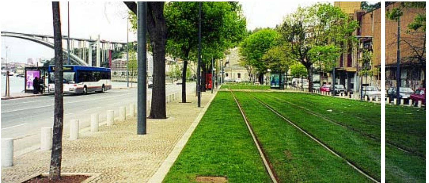
Φωτ. 2.13. Porto, Πορτογαλία. Παραλιακή γραμμή τραμ. Τμήματα του διαδρόμου είναι καλυμμένα με γκαζόν.
